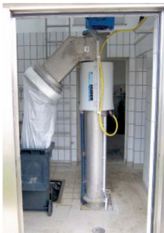
Deposição simples dos resíduos pelo tamisador HUBER ROTAMAT® RoK 4 com ensaque hermético em contentor
