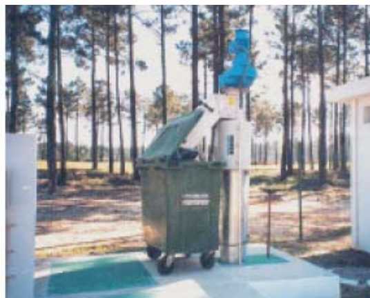
Instalação do tamisador HUBER ROTAMAT® RoK 4 no exterior a economizar espaço
