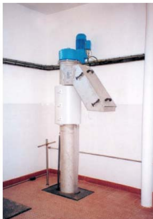
Instalação do tamisador HUBER ROTAMAT® RoK 4 dentro de um edifício a economizar espaço
