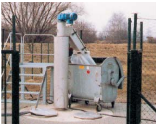
Tamisador HUBER ROTAMAT® RoK 4 versão com aquecimento no exterior
