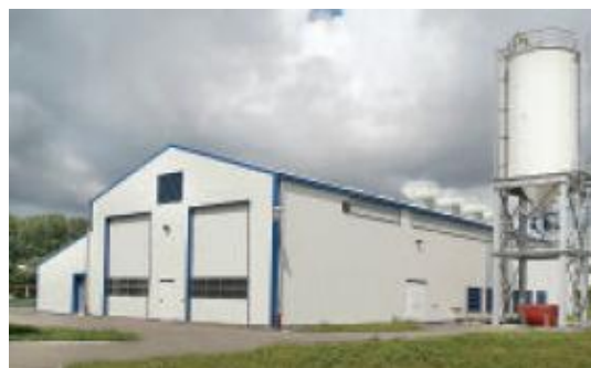
Secagem HUBER pronta-a-funcionar com duas linhas e um silo de resíduos secos
